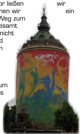
Der Mannheimer Wasserturm
